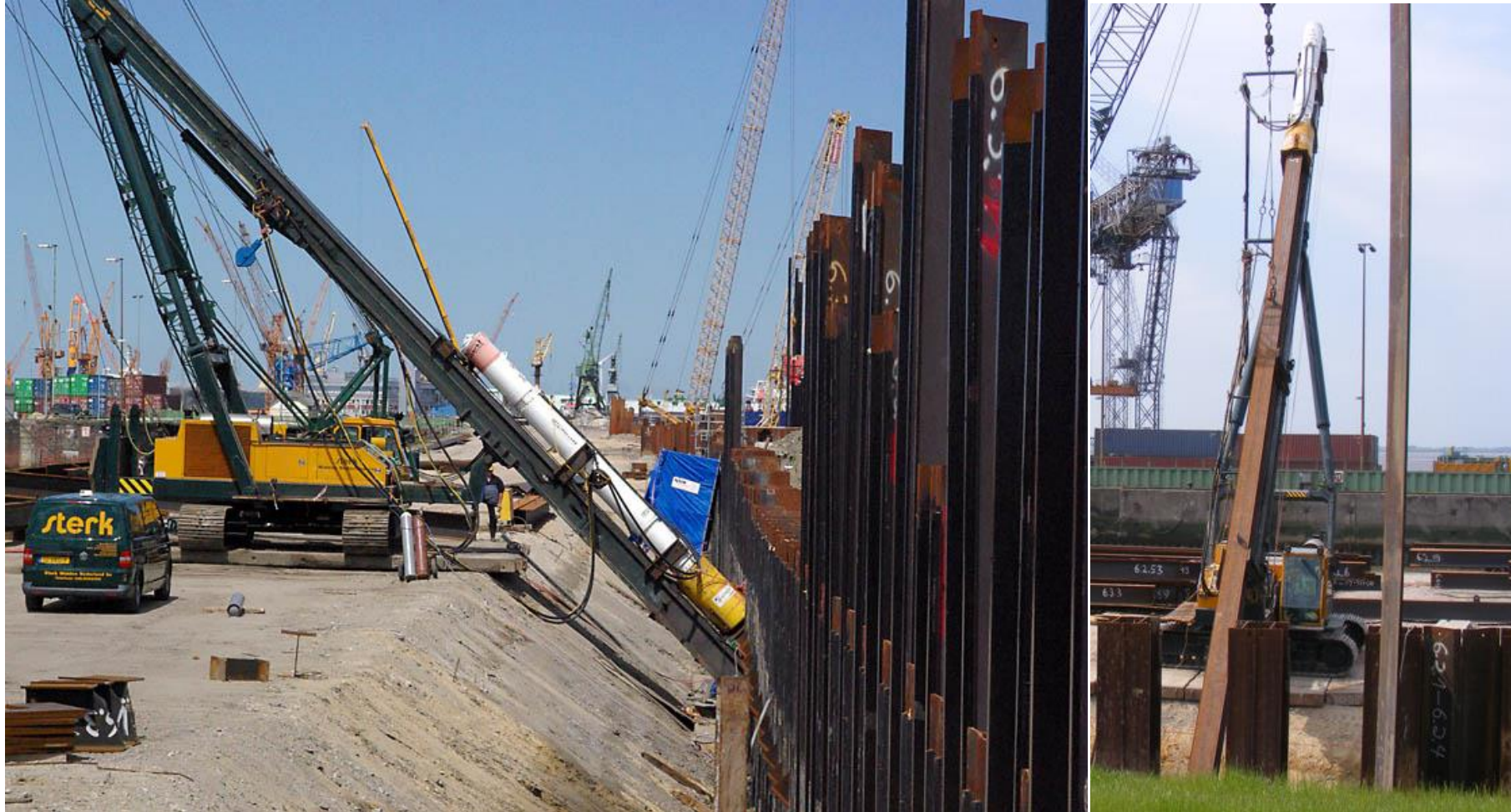
Driven piles, length 60 m, Peiner Stahl PSt 600 mm
