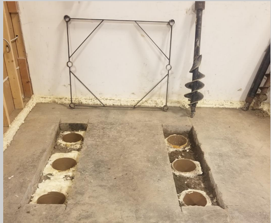
Sono tubes installed
